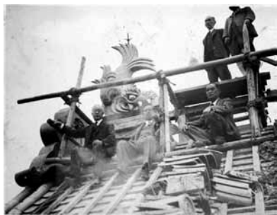
長崎県福濟寺修理工事現場 左が関野貞
